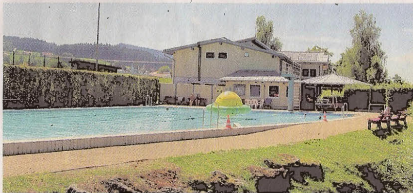
Das große Becken im Weilerer Freibad ist sanierungsbedürftig. Jahr für Jahr fallen die gleichen Reparaturarbeiten an. Archivfoto: David Haas
